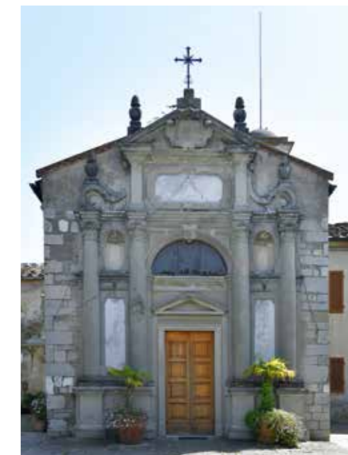
Chiesa di S. Andrea in Pescaiola, facciata con il finestrone del coro della chiesa di Santa Caterina
