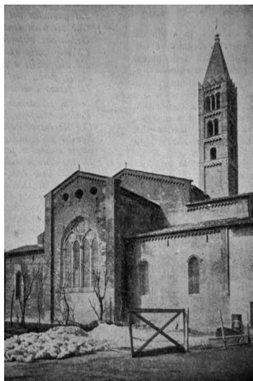
Il restauro del campanile nel 1930
